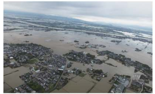
広範囲で浸水被害が発生[福岡市消防局 提供]
