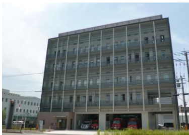
東出張所（筑後地域消防指令センター）
