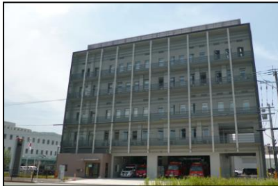
東出張所（筑後地域消防指令センター）
