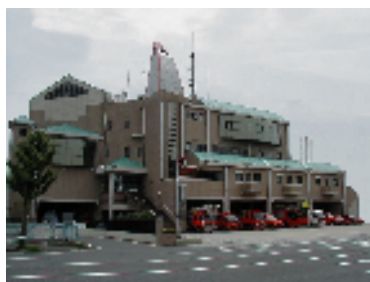
久留米広域消防本部・久留米消防署
